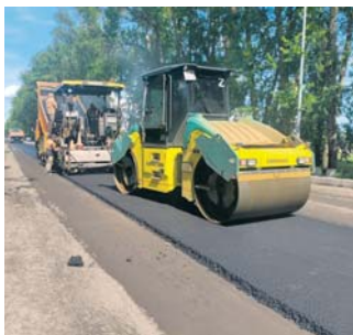
Укладка асфальтобетонного покрытия
