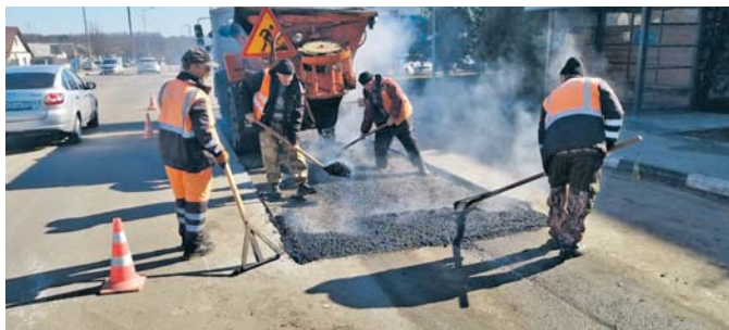
Ямочный ремонт дороги
